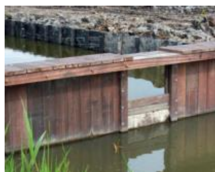
Voorbeeld van knijpconstructie
